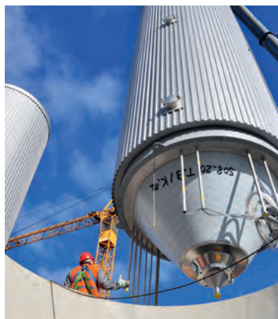
Insgesamt 12 neue Gär- und Lagertanks wurden in den vergangenen Tagen am Standort der Störtebeker Braumanufaktur installiert. (Fotografin: Christine Lorenz)
